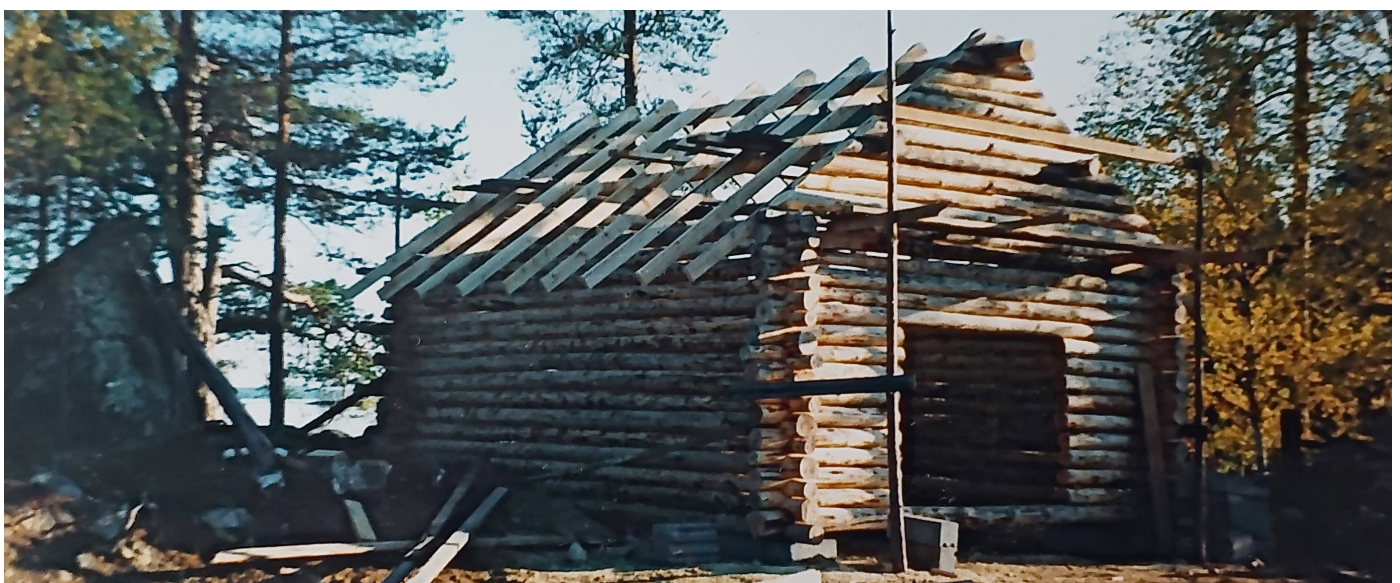
Ja tässä lopputulos valmiina harjakaisten juhlintaa varten.
